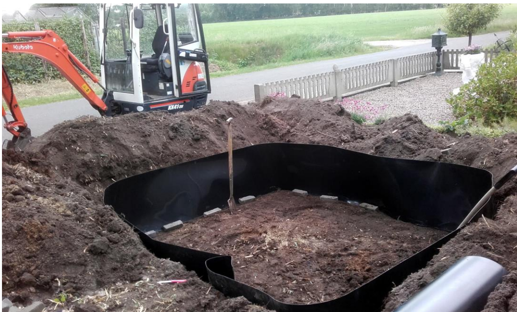
Boven: \pm 10 \text{ m}^2 bestemd voor een reuzenbamboe ( P. parvifolia ) in een voortuin Onder: teruggevouwen uiteinden, in elkaar gehaakt en tussen 2 strips vastgeklemd
