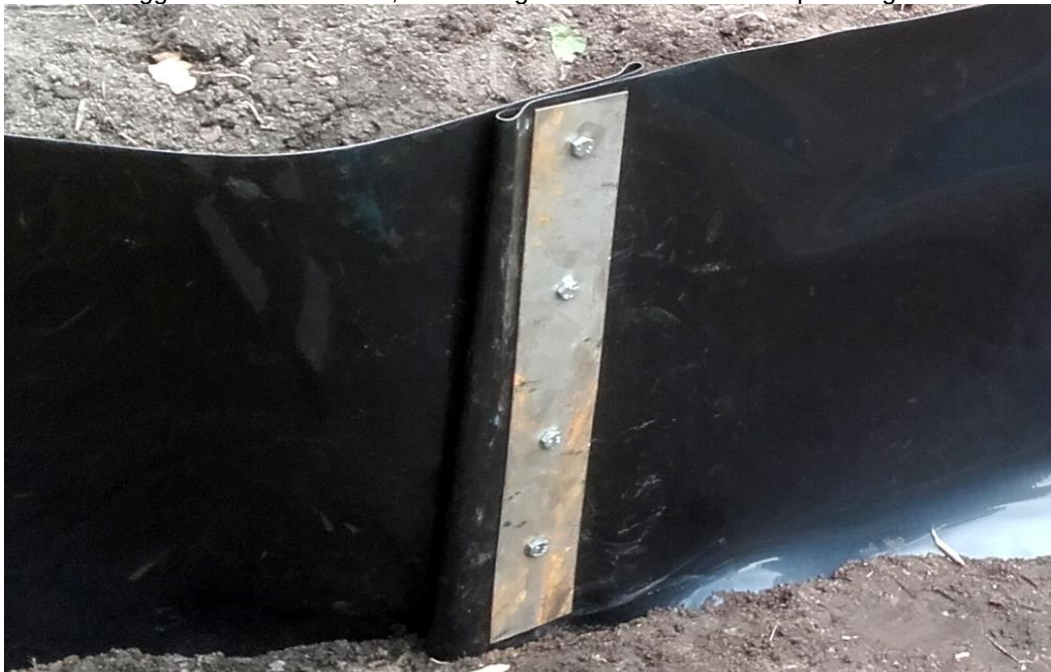
Boven: \pm 10 \text{ m}^2 bestemd voor een reuzenbamboe ( P. parvifolia ) in een voortuin Onder: teruggevouwen uiteinden, in elkaar gehaakt en tussen 2 strips vastgeklemd
